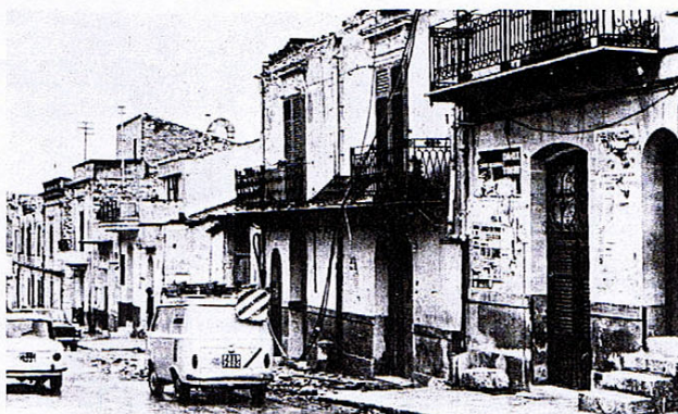
San Giuseppe Jato: una immagine delle distruzioni operate dal terremoto
