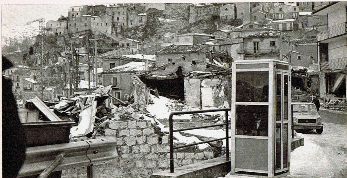
Telefoni tra le rovine. La SIP ha ristabilito la presenza del servizio dove più si rendeva necessario. Qui siamo all'ingresso di Castelgrande; la cabina, installata a pochi metri dalla centrale andata fuori uso, è stata collegata alla rete con un allacciamento d'emergenza.
