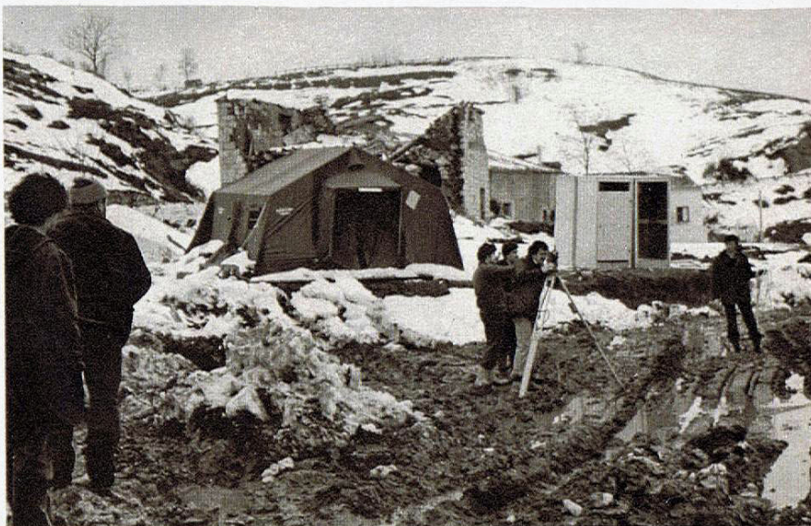
E' iniziata la ricostruzione. Periferia di Castelgrande: nel paesaggio sconvolto alcuni tecnici procedono a rilevazioni sul terreno per l'installazione di prefabbricati.
