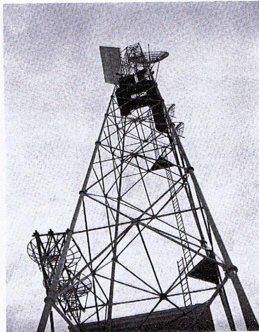
Sulla torre di Montagano un grande specchio d'antenna devia verso Guglionesi il fascio elettromagnetico dei paraboloidi posti in basso e visibili nella foto di destra (scattata quando i lavori erano ancora in corso); nella foto di sinistra, definitiva, si vedono pure i paraboloidi verso Agnone, quelli verso Campobasso e quello con Isernia in basso.
