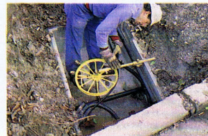
Alcune fasi della posa in opera dei cavi in fibra ottica a Soverzene. Qui la qualità del servizio ha modelli futuristici.
